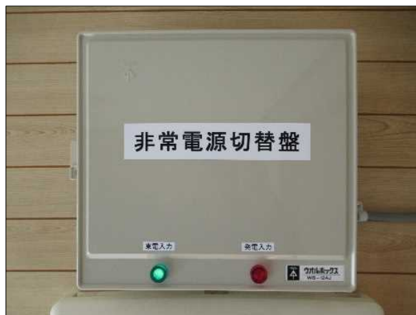
配電盤の上部に設置した非常電源切替盤
