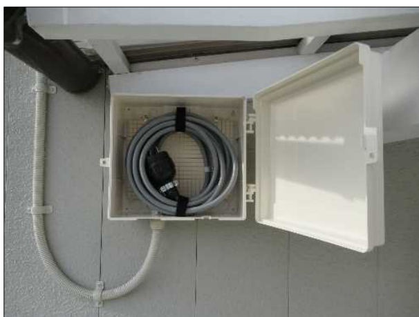
発電機接続ケーブルは、館外の収納盤に収納
