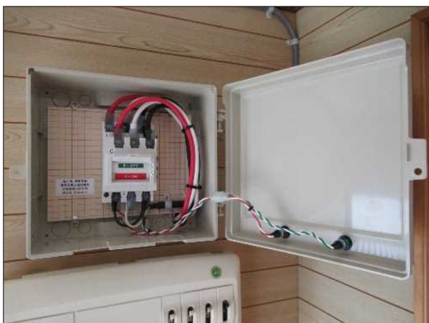
商用電源と発電機の電源をレバーで切り替え
