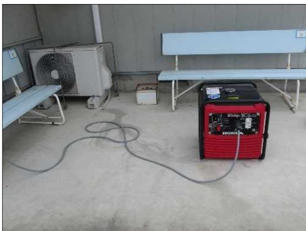
非常電源切替盤と発電機を接続
